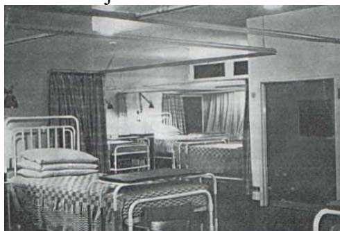
Figura 2 – Enfermaria de hospital com iluminação indireta combinada à iluminação localizada junto aos leitos.
