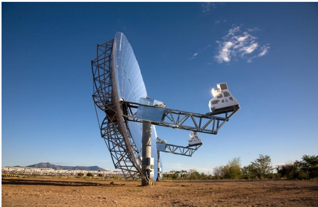
Figura 16 – Concentrador de disco parabólico
