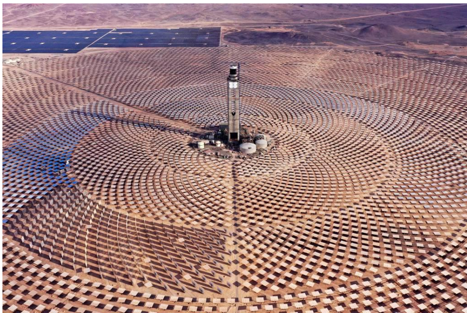
Figura 19 - Usina Cerro Dominador, no Chile.
