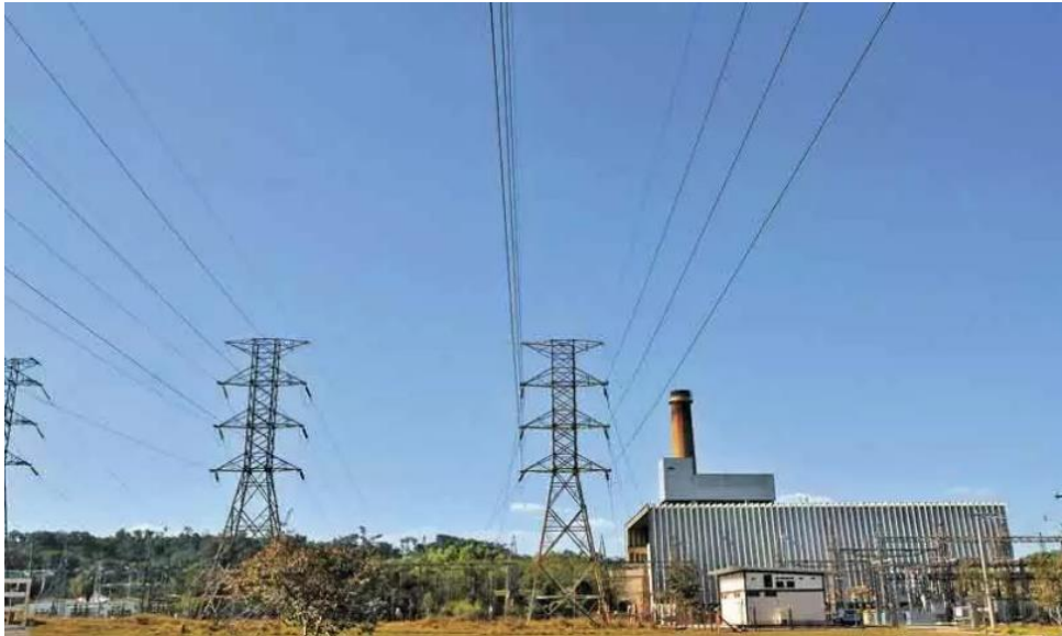
Figura 12 - Usina termelétrica de Igarapé, MG
