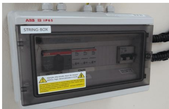
Figura 10 - Ilustração de um modelo de String-Box
