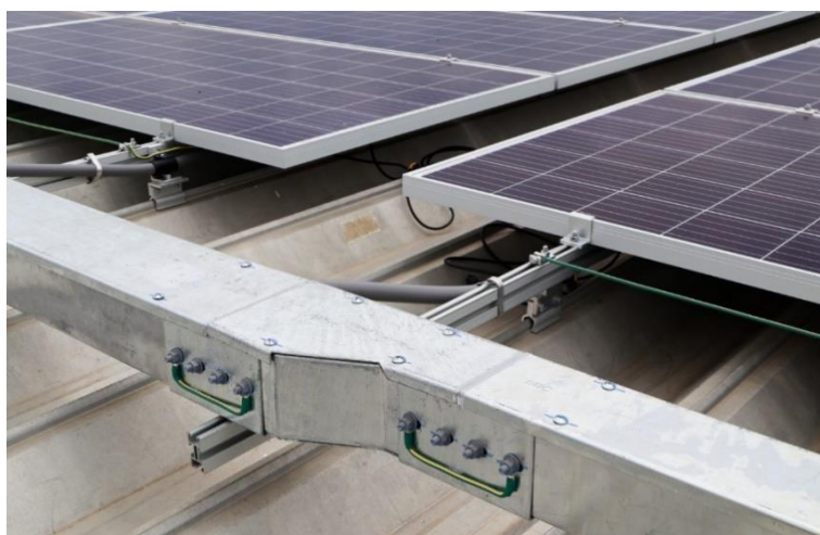
Figura 11 - Sistema de aterramento
