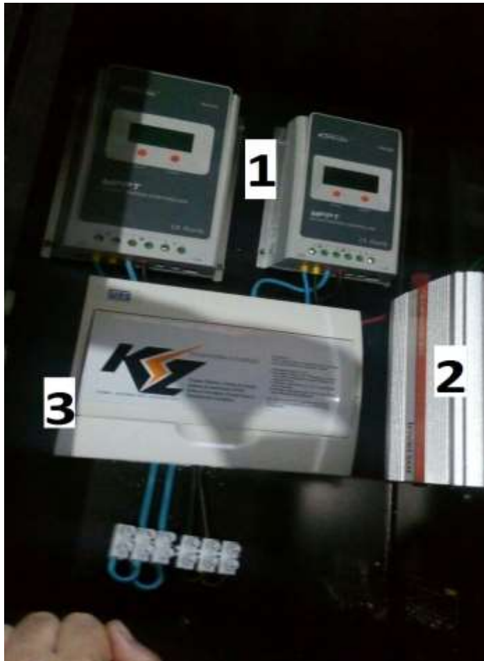
Figura 35 - Resultado final da instalação do quadro de controle do SFI.
