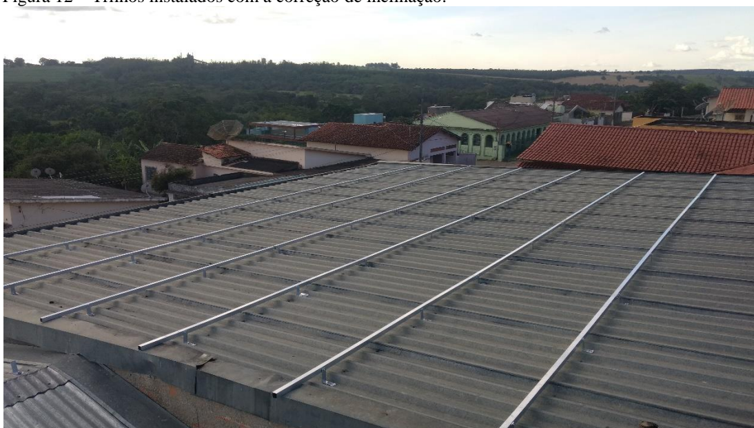
Figura 12 – Trilhos instalados com a correção de inclinação.
