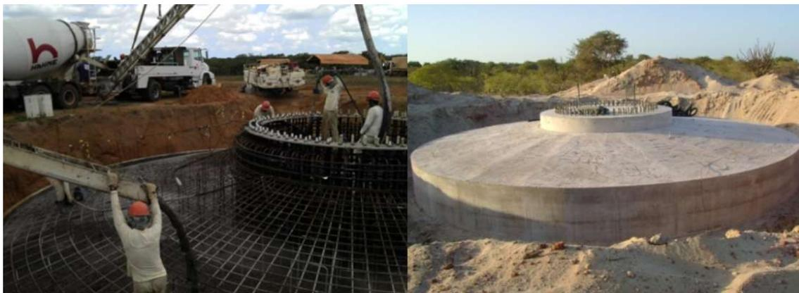
Figura 8 – Fundação recebendo a concretagem(esquerda) e finalizada esperando para receber a torre (direita).
