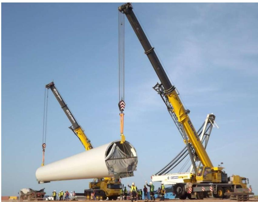
Figura 9 – Içamento do segmento de uma torre de energia eólica.
