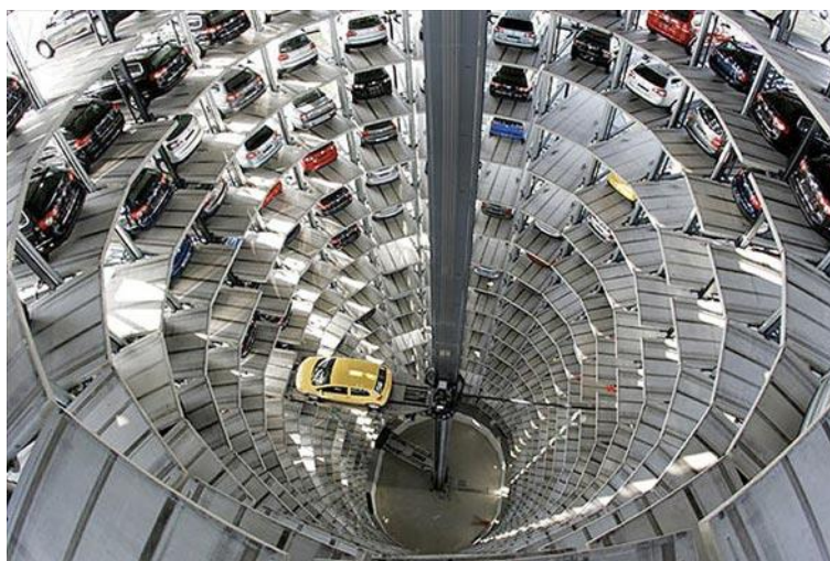
Figura 5 Estacionamento subterrâneo de automóveis.
